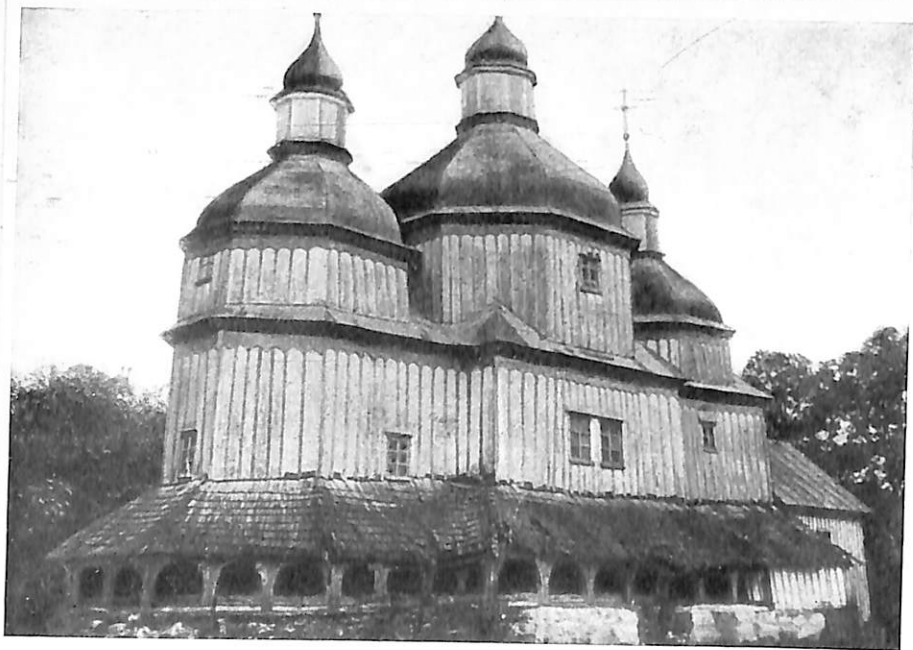
Опасання на арках, церква у с. Іванківці Хмельницької обл., XVIII ст.
