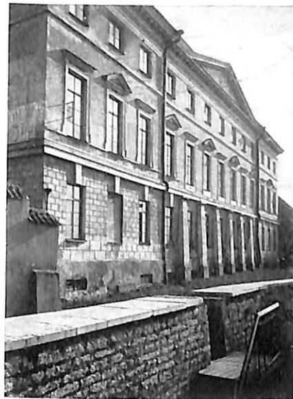
Фасад бывш. губернского суда по ул. Рахвоохту, 3. 1784—1792
