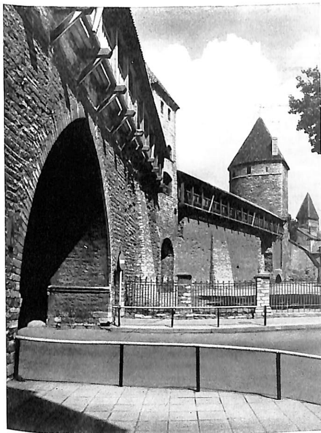
Реставрированный участок городской стены по ул. Ноорусе
