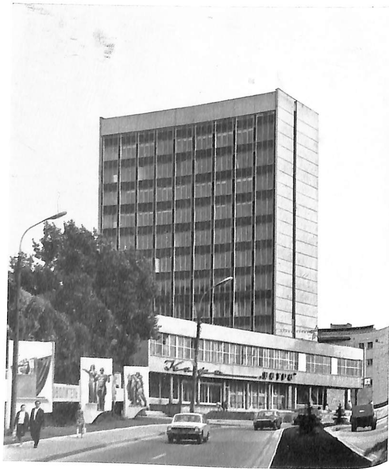
111. Здание Вычислительного центра на ул. 700-летия Львова
