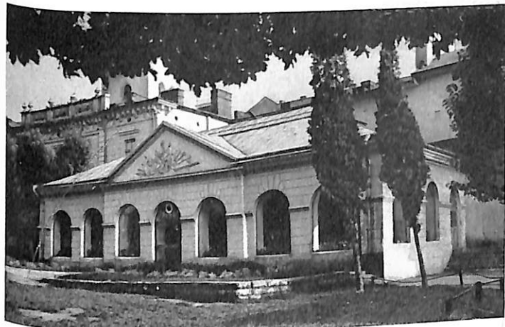
86. Здание Б. гауптвахты
